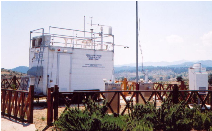
Σχήμα 1: Σταθμός Παρακολούθησης ποιότητας του ατμοσφαιρικού αέρα στην Αγία Μαρίνα-Ξυλιάτου
